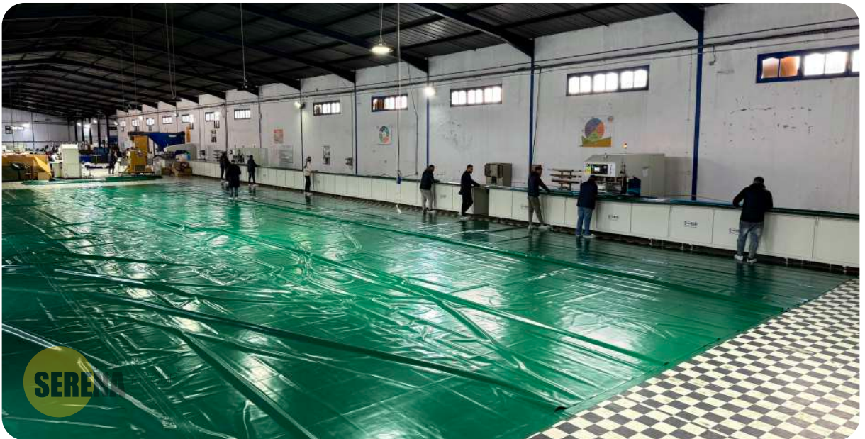
Fabrication d'une citerne de 1000 m 3
